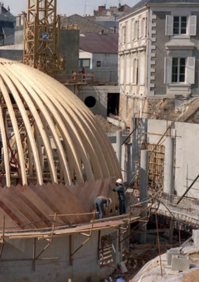
Coulée du béton du voûtement.
