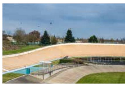
Le vélodrome est construit en béton avec de la résine silice pour le revêtement. La piste mesure 250 m de long et 7 m de large. Elle est inclinée à 43° dans les virages. Elle est homologuée par la Fédération française de cyclisme.
